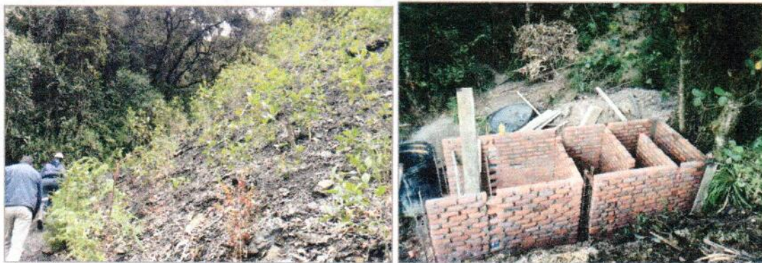
Actividades ambientales Mina La Azulita: Recuperación de botaderos, adecuaciones de sistemas de tratamiento de aguas residuales.
